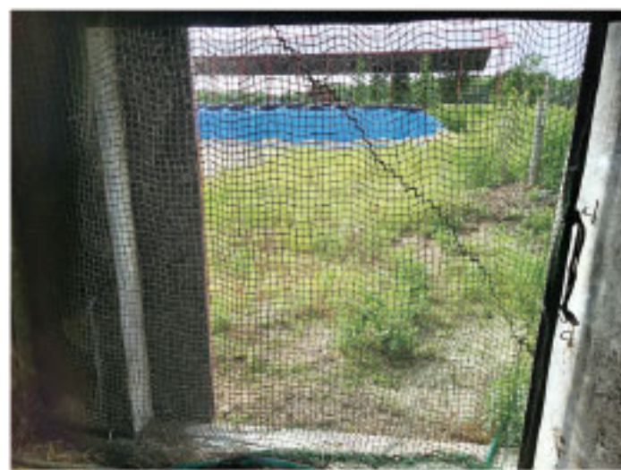
写真2 既存の動物侵入防止ネットの上に昆虫駆除のネットを設置した様子
