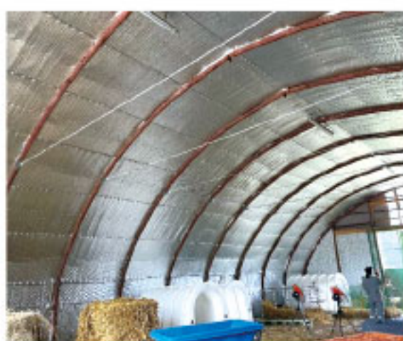
写真2 D型ハウス内壁に遮熱シートを施工した事例
