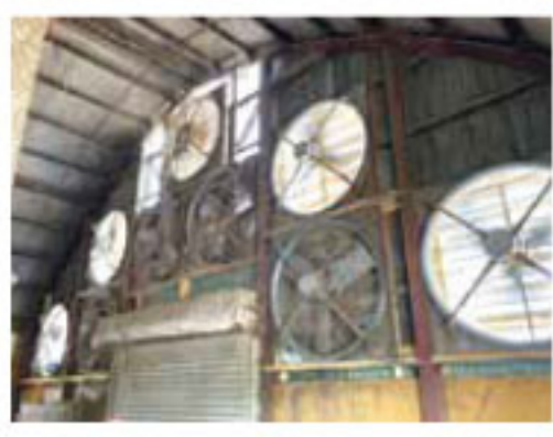
写真③ 換気扇の増設
