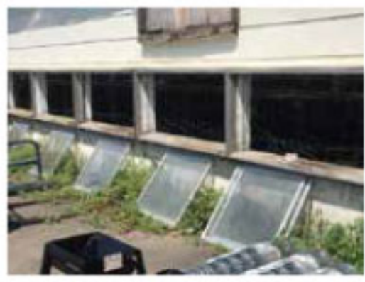
写真② 窓を取り外した牛舎
