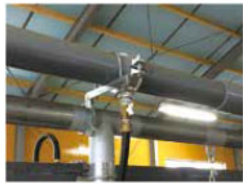
写真④ ウォーターカップの配管を太くする
